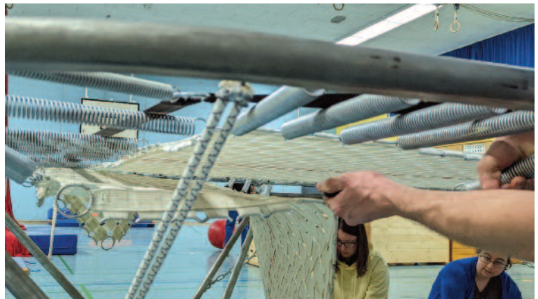
Renovierung des Großtrampolins
